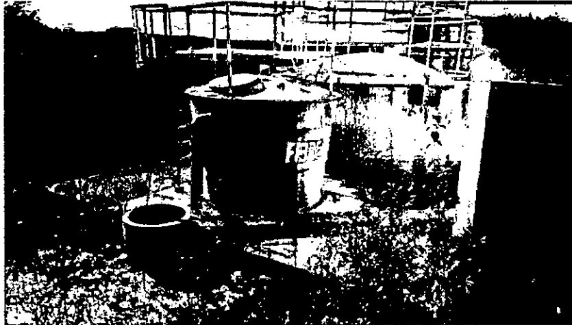
FOTO 10: ESTAÇÃO COMPACTA DE TRATAMENTO DE ESGOTO SANITÁRIO.
