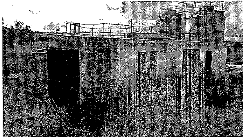
FOTO 09: ESTAÇÃO COMPACTA DE TRATAMENTO DE ESGOTO SANITÁRIO.
